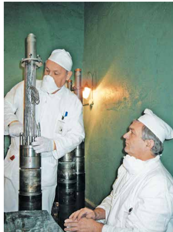
Монтаж термопреобразователей и УК-1 на стояке канала
