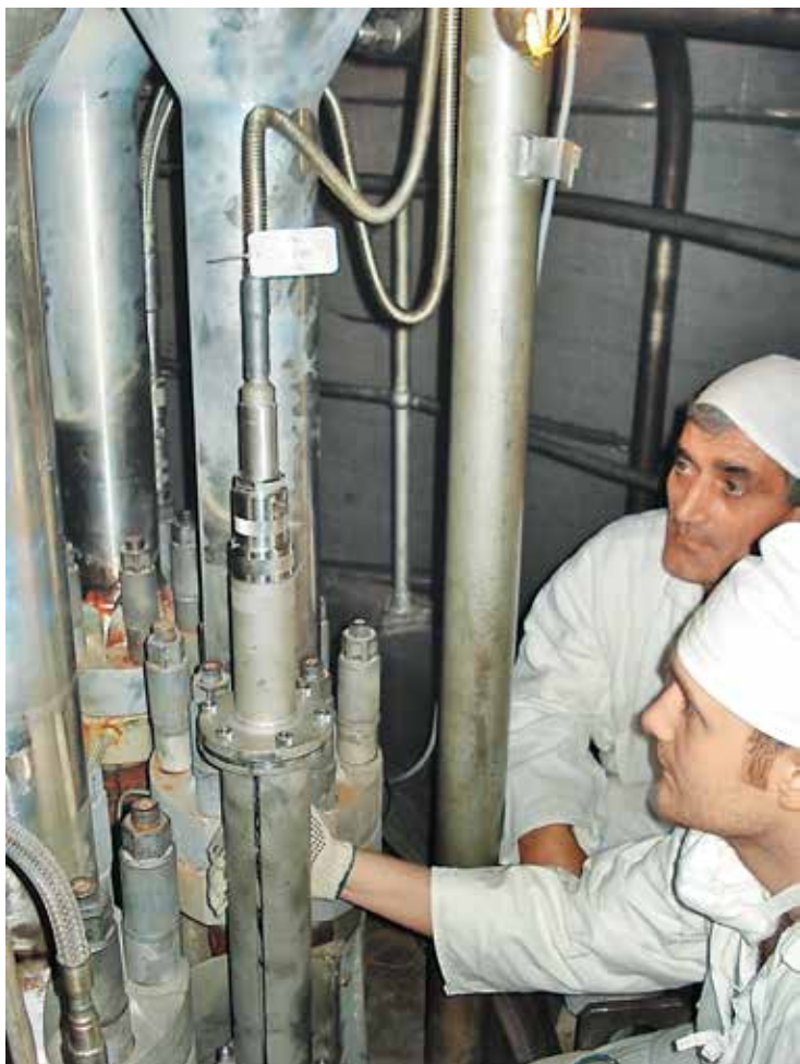
Монтаж УК-1 с шлейфом на стояке канала
