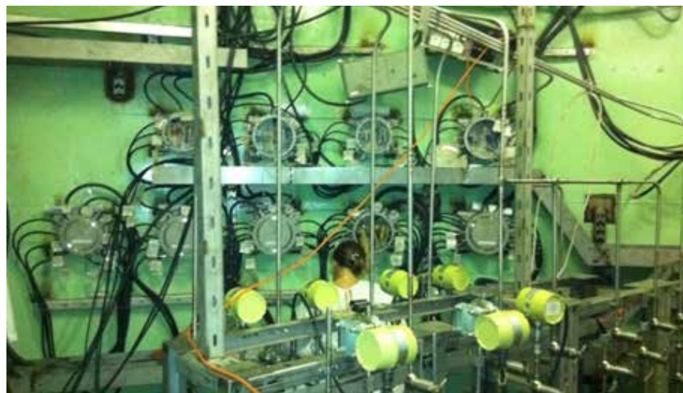
Монтаж СКТ на АЭС
